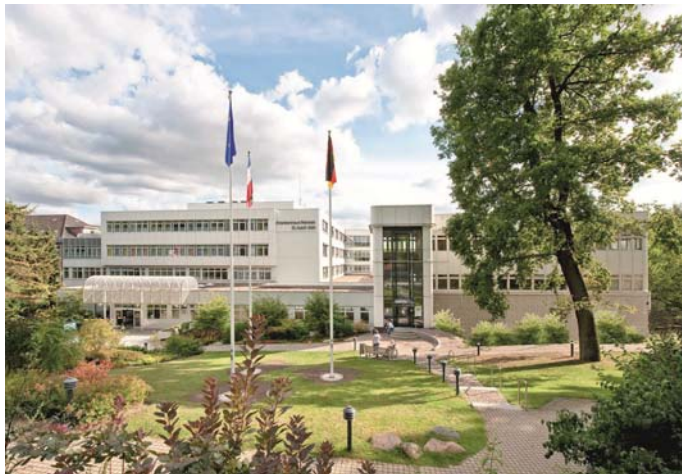
Ansicht des Krankenhauses Reinbek
